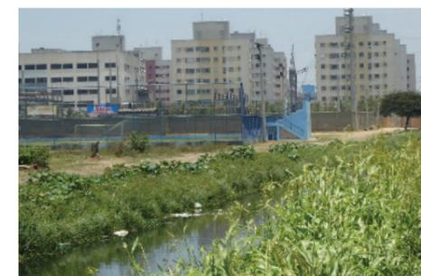
⑥ Parte do canal sem contenção, com estreitamento e maior acúmulo de lixo e assoreamento.
