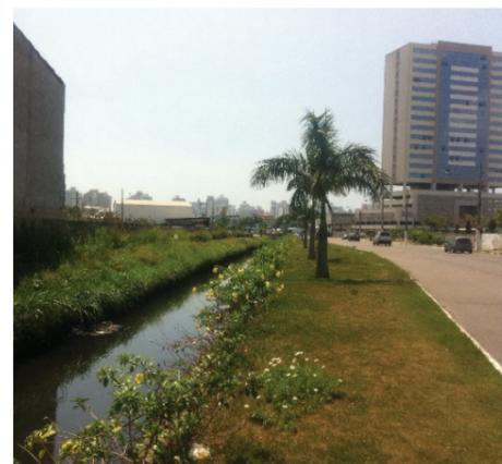
⑤ Parte do Canal com contenção, com muito assoreamento e trecho mais arborizado. Observação: Em todo o Canal da Costa são lançados esgoto sanitário e lixo, jogados por moradores do entorno, tornando toda a extensão do canal em área alagável.
